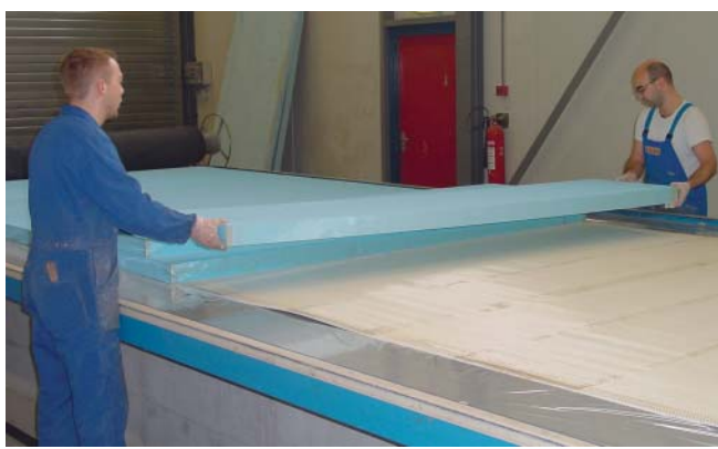
Fig. 7 Posizionamento delle lastre STYROFOAM
